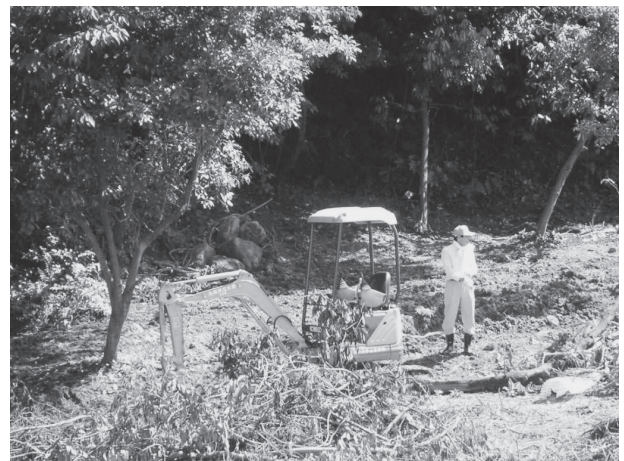
図6 小型建設機械による造成作業
