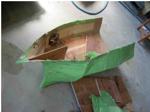
型枠の外した殻
