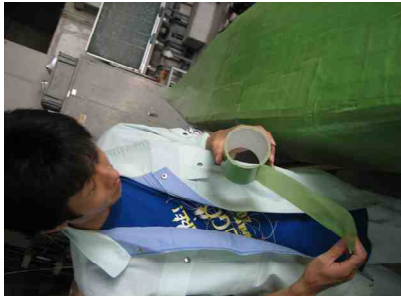
ラワン合板完了後、養生 貼り付ける
