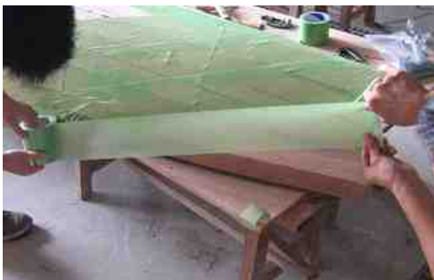
コンクリートの付着をなくすため に、船体周りに養生テープを貼り付 ける。
