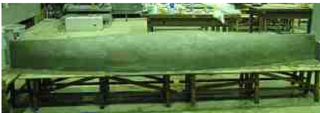
オリジナル軽量モルタル塗り完了
