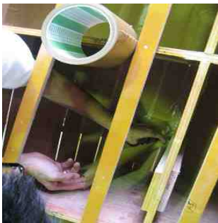
3 mmのラワン合板 T1F3、貼り付け完了。
