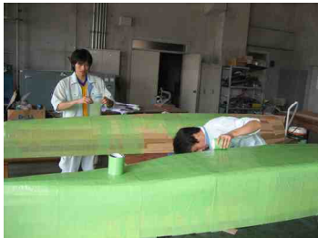
貼り付け作業中
