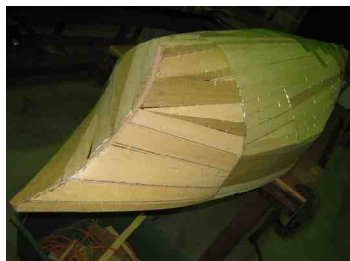
ラワン合板 貼り付け完了
