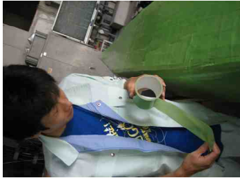
ラワン合板完了後、養生 貼り付ける
