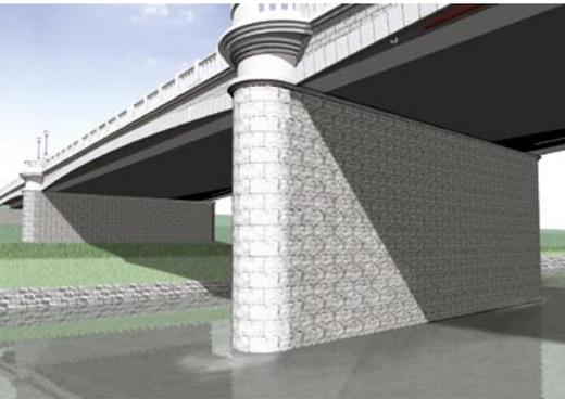
上は芳雄橋の完成イメージ。右の写真は、完了した芳雄橋の下部工事。左に見えるのは仮橋。5本の橋脚と2基の橋台を建設した。橋脚は、白御影石を使った石積み型枠で施工した。上部はPC6径間連続中空床版橋。現在、富士ピー・エスが施工している。橋長は217.5m。2008年12月に開通予定
