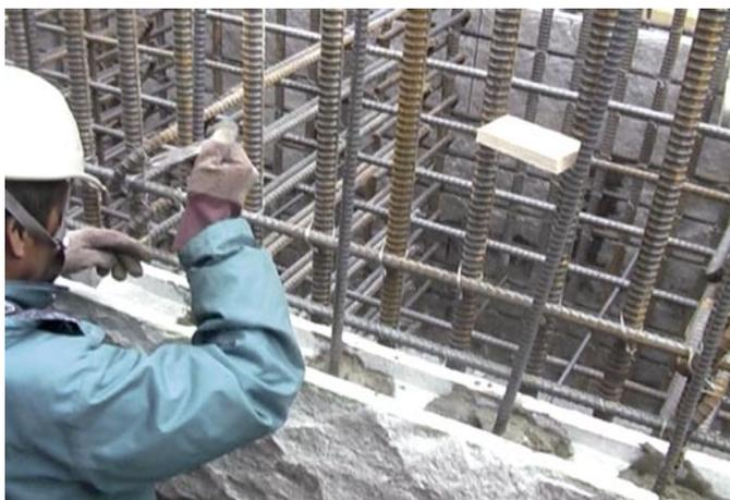
鉄筋を通すブロックの貫通孔に軟らかめのモルタルを充てん。突き棒を使って人力で締め固めた
