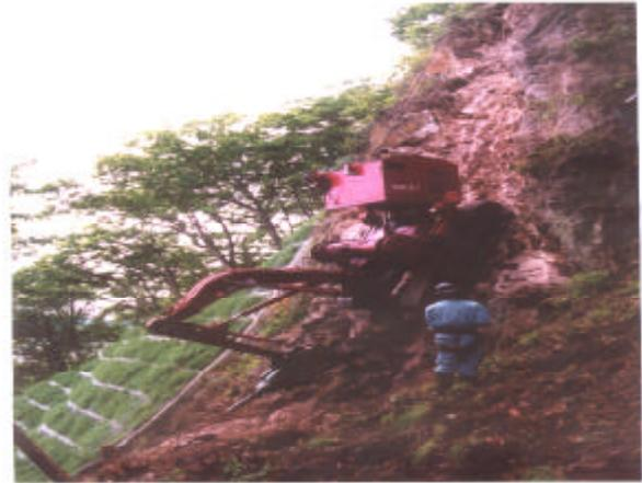
写真 - 3 : 遠隔操作による掘削状況
