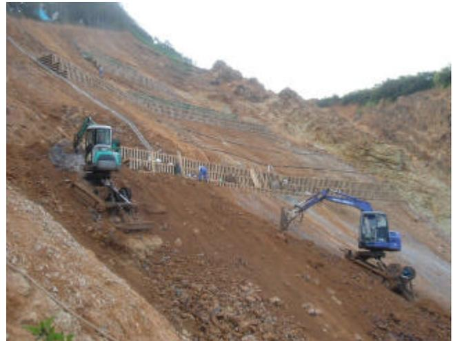
写真 - 1 : オペレータが操縦するバックホウによる法面掘削の状況
