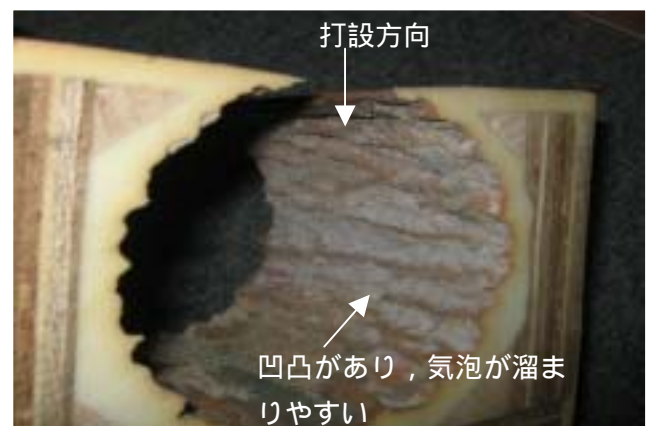
写真-3 型枠の木目写真
