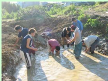
大池の造成(天然材料使用)
